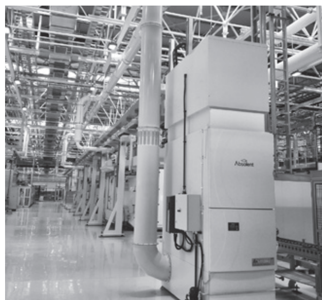
集中配管タイプの設置例： Volvo Zhangjiakou工場/A・mist 80TF
